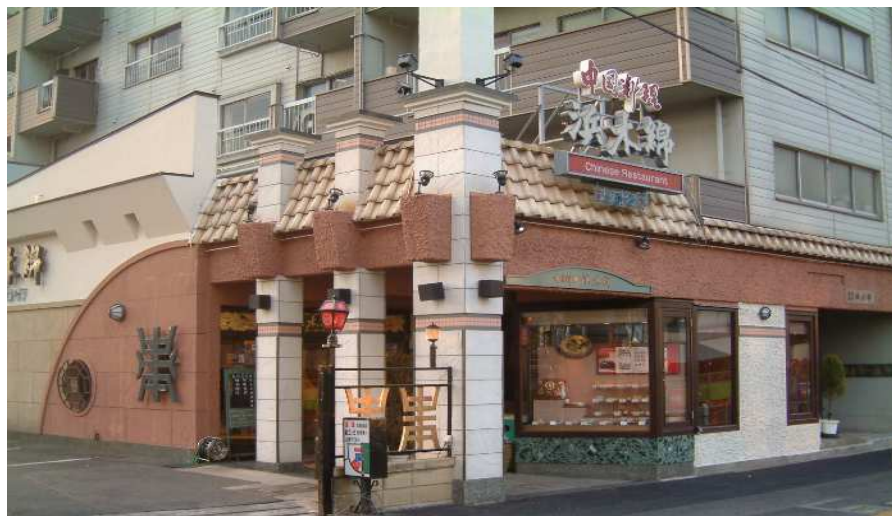
山手通本店、本社ビルの全面建て替え
